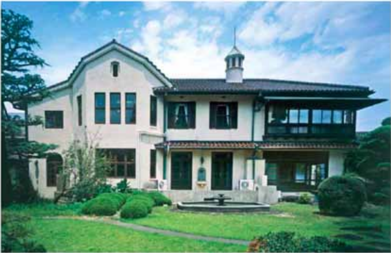
FIG.8 新田利國邸の洋館南面と庭園 出典：『INAX REPORT』No. 189（株式会社 LIXIL、2012年）
